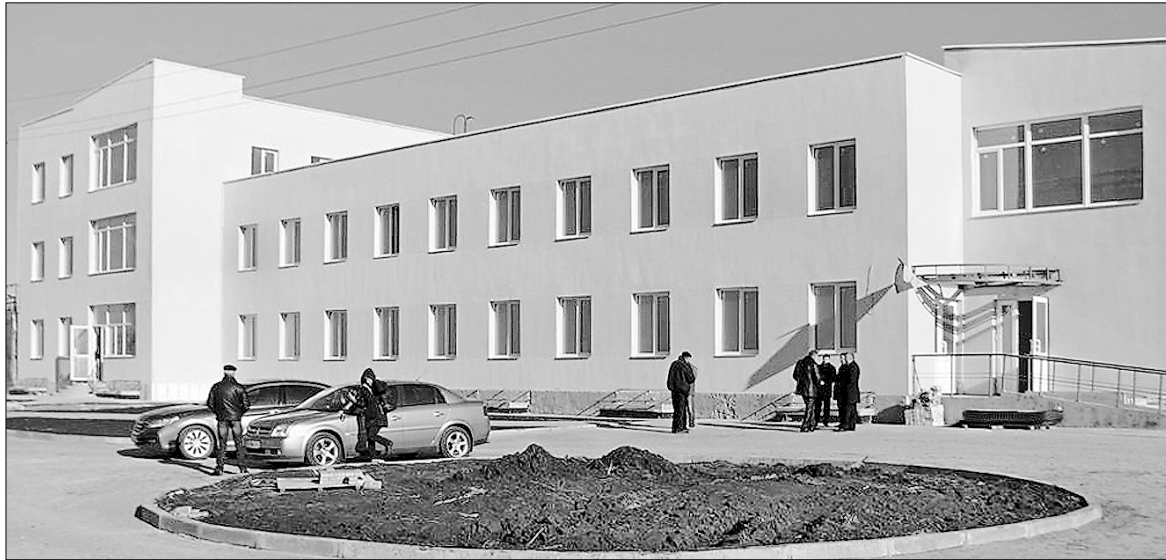
Завершення будівництва поліклініки в селищі Кушугум Запорізького району
