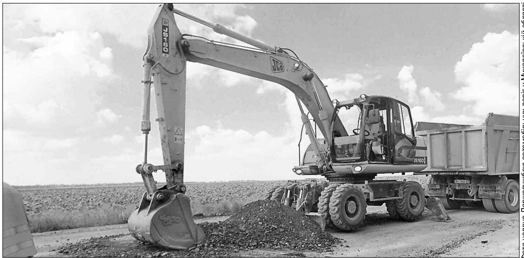
Ремонт траси здійснюють за новітньою технологією
