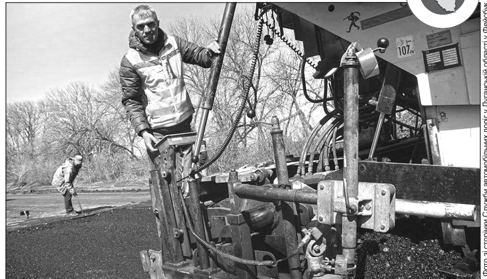
Автошляховики вже укладають нижній вирівнювальний шар асфальтобетону на дорозі державного значення Н-26 Чугуїв — Мілове
