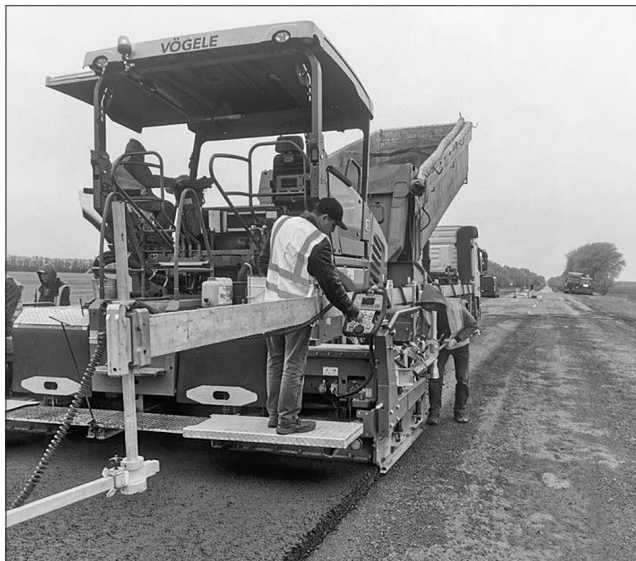
Повним ходом триває ремонт доріг на Сумщині
