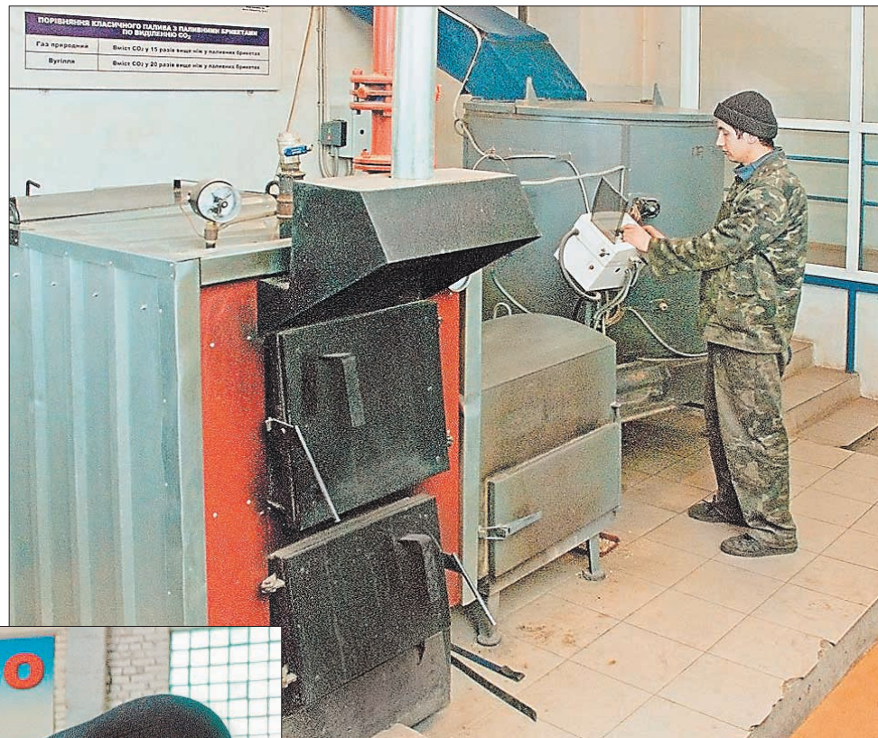
Ось такі котли з автоматичною подачею трісок і брикетів передає школам на умовах оренди комунальне підприємство «Віноблагроліс»
