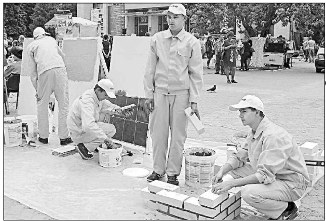
У будівельники піду, хай мене навчать...
