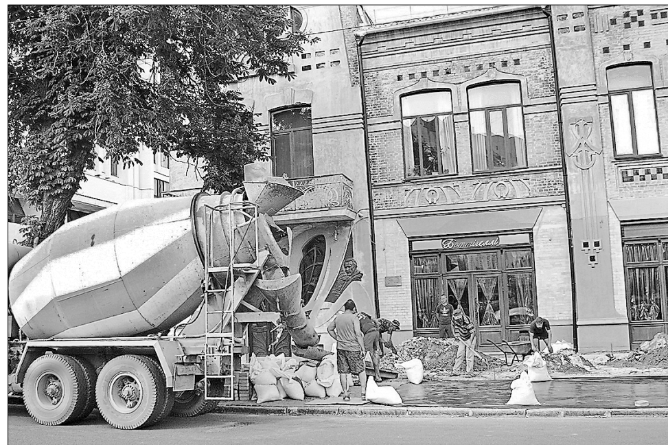
Будівництво тераси ведуть швидкими темпами
