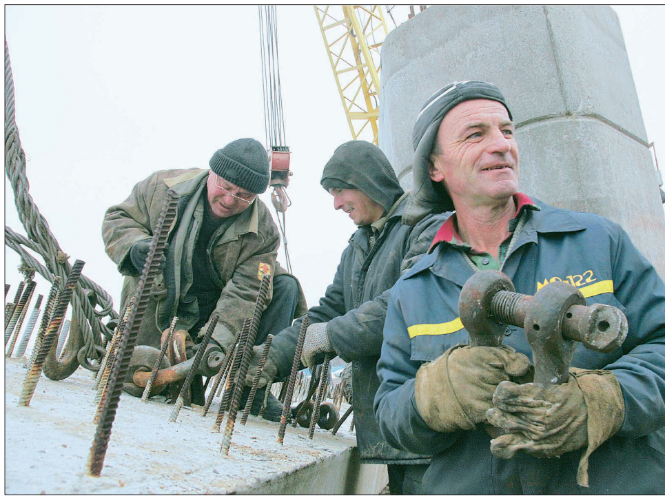
Триває будівництво мосту через Дніпро
