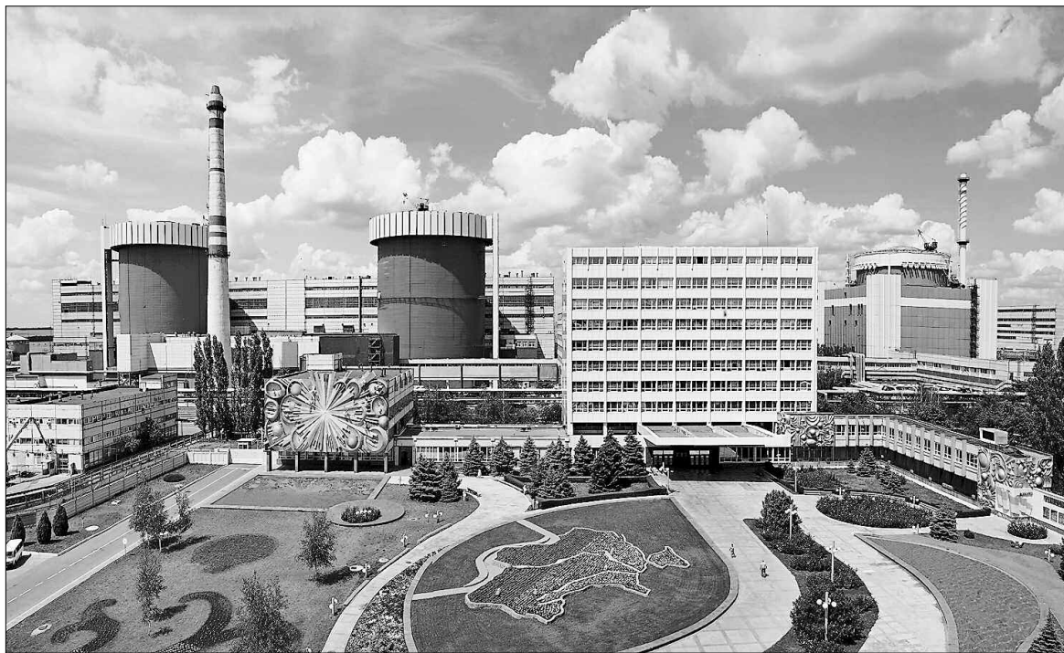
В атомній енергетиці головне — безпека експлуатації енергоблоків
