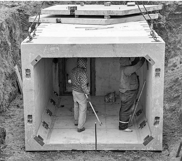
Модульні укриття встановлюють у заглибинах у землі
