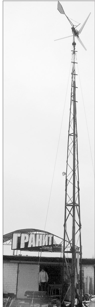
Леонід Кізяєв за лічені тижні змайстрував і встановив вітрогенератор. Нині його висота вже 13,5 метра
