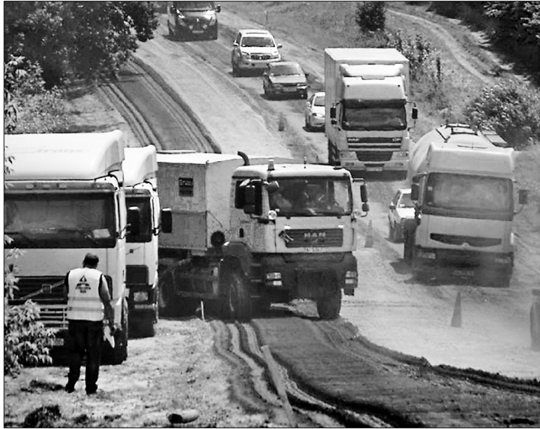
Ремонт шляхів відбувається із використанням нових технологій
