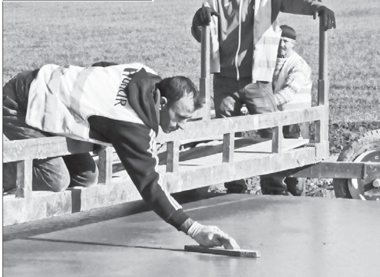
Метрова подушка — глина, гравій, пісок, цемент, арматура, бетон — робить дорогу не лише надійною, а й довговічною. Принаймні турецькі шляховики гарантують безремонтну експлуатацію (за умов належного догляду) протягом 30 і більше років
