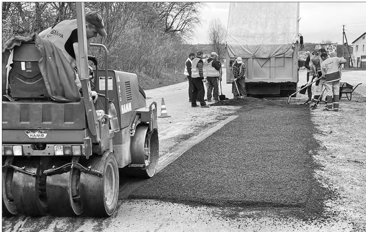
Тернопільські дорожники ремонтують одну з ділянок автошляху
