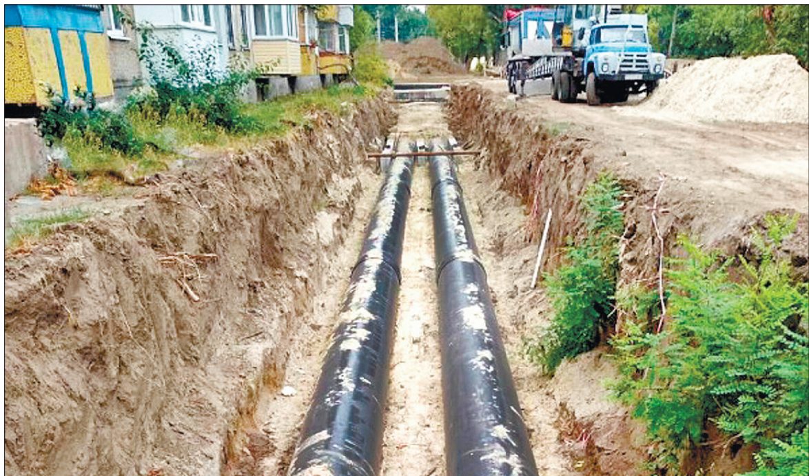
Нові труби, які вже укладено під час реконструкції магістрального трубопроводу на вулиці Симиренківській у Черкасах, дадуть змогу підвищити надійність та якість теплопостачання
