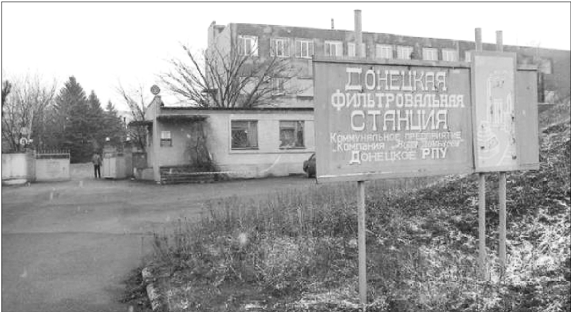
Донецька фільтрувальна станція, яка забезпечує водою населені пункти на підконтрольній Україні території і на окупованій, зараз працює, але через обстріли її об'єкти мають пошкодження
