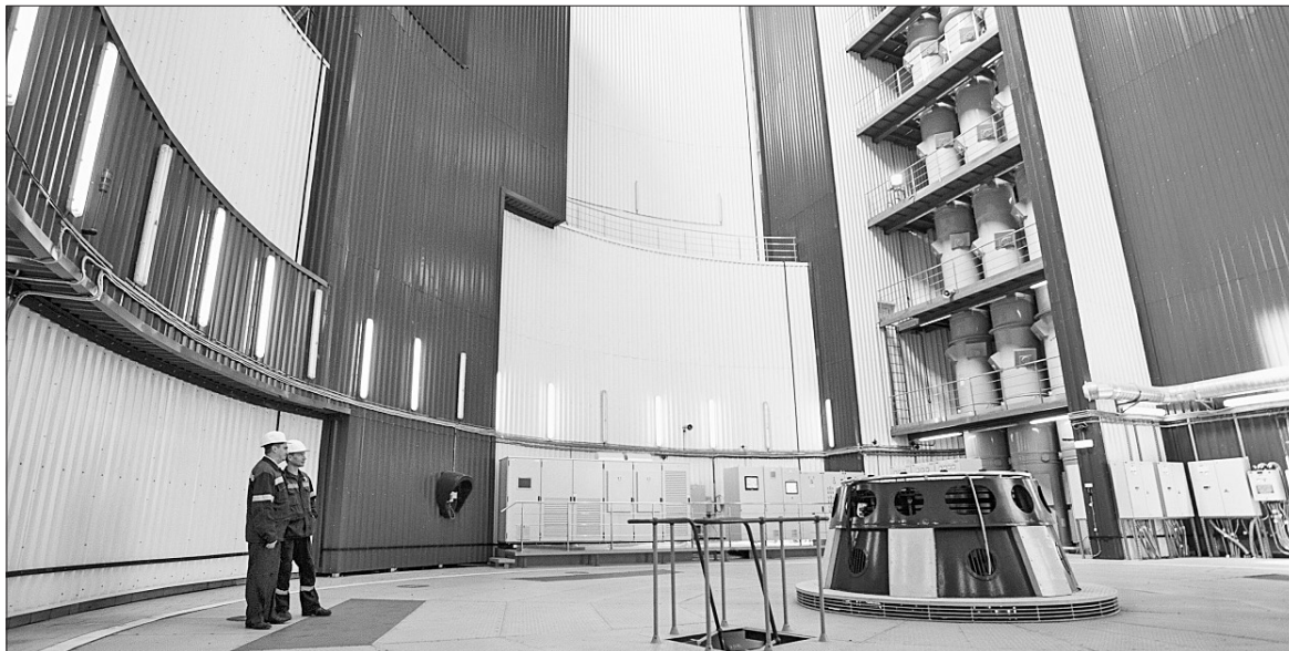
Гідроенергетики цілодобово контролюють технічний стан споруд станцій
