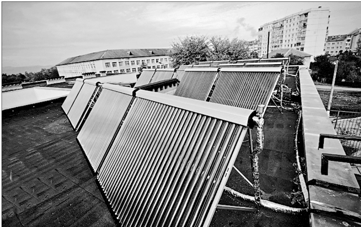
Сонячний колектор на даху дитячого садка «Золота рибка»
