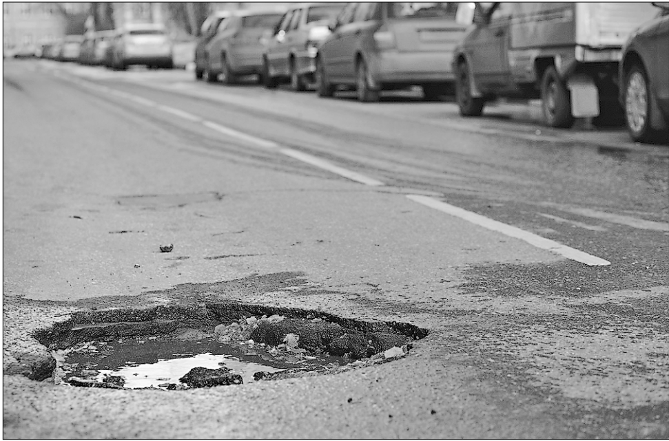
Кошти на ремонт доріг є, та освоювати їх місцева влада чомусь не поспішає
