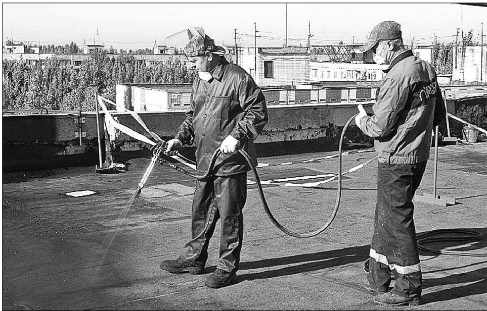
Для захисту даху достатньо покрити його гумовим шаром завтовшки лише два міліметри
