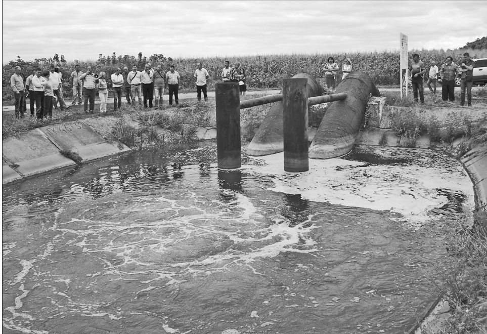
3 аванкамери дніпровська вода потрапляє в магістральний канал завдовжки 11 кілометрів
