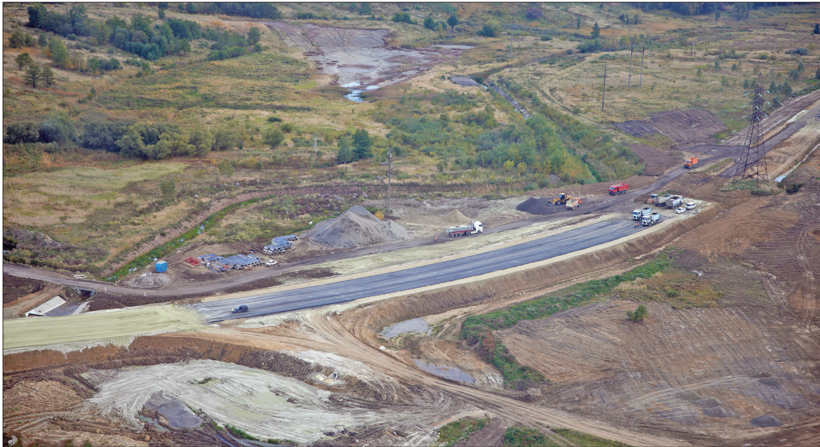
Зведення об'їзної дороги навколо Трускавця — частина автомобільної дороги державного значення Східниця — Пісочна — відбувається в межах програми «Велике будівництво»
