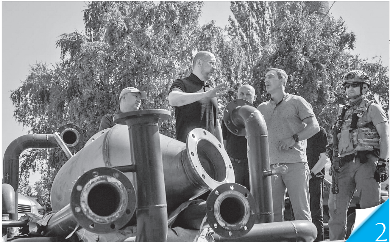
Денис Шмигаль особисто перевіряв реконструкцію об'єкта теплової генерації
