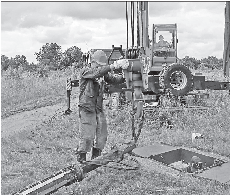
Фахівці водоканалу здійснюють генеральну перевірку артезіанських свердловин
