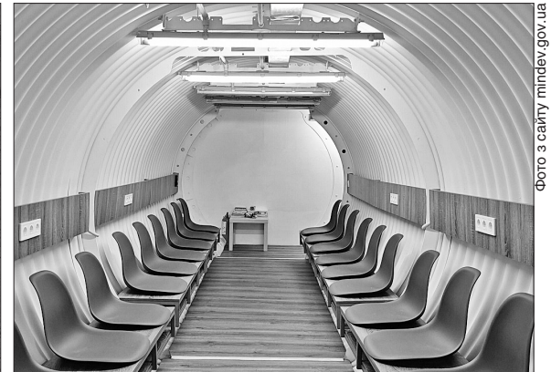
Конструкцію, яка забезпечує захист від уламків, ударної хвилі, хімічного ураження та радіоактивного пилу, змонтували за кілька тижнів
