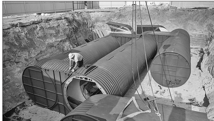
Конструкцію, яка забезпечує захист від уламків, ударної хвилі, хімічного ураження та радіоактивного пилу, змонтували за кілька тижнів
