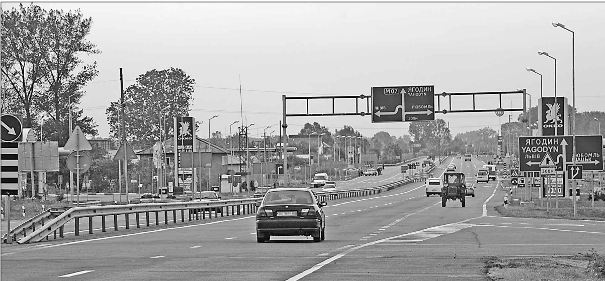
Сучасна дорога — досить складна і дорога інженерна споруда, що не тільки забезпечує комфортність пересування, а й підвищує безпеку при цьому
