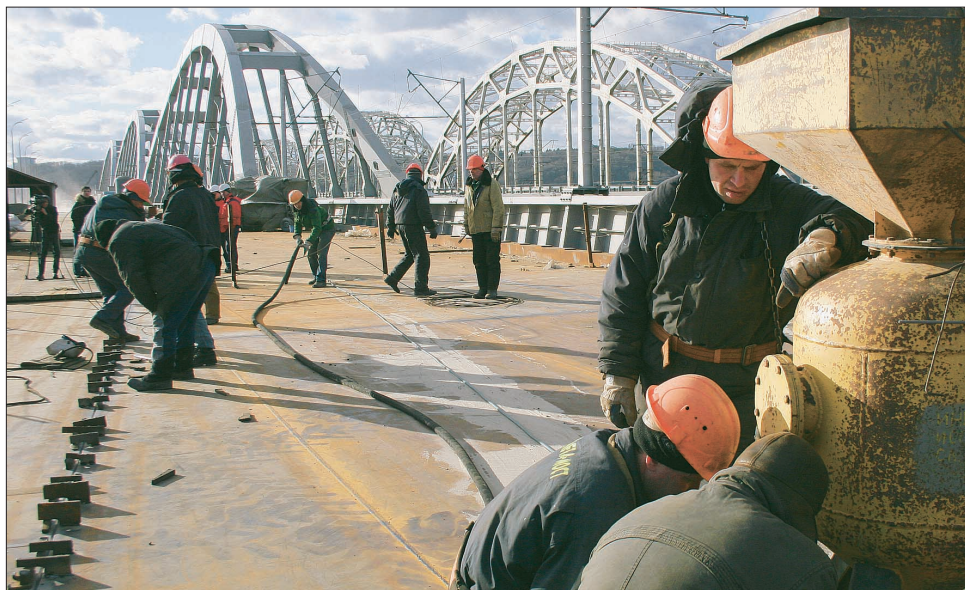
Близько тисячі робітників цілодобово наближають введення в експлуатацію Дарницького мосту
