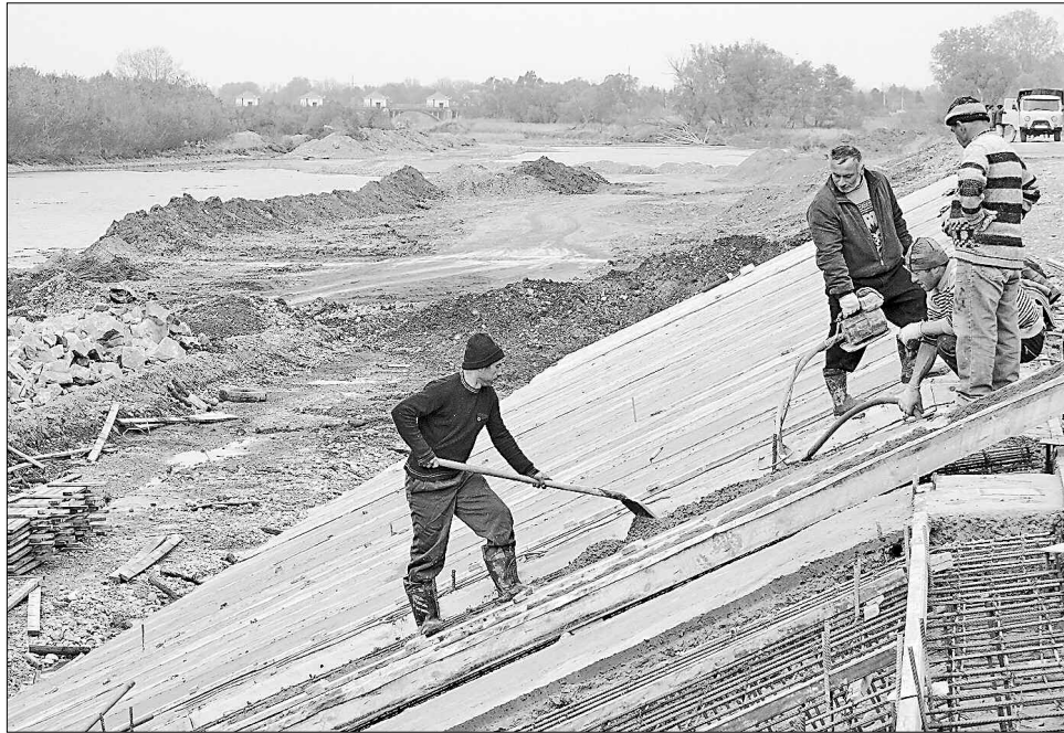
Аби гірська річка під час розливу не підмила трасу, її береги укріплюються
