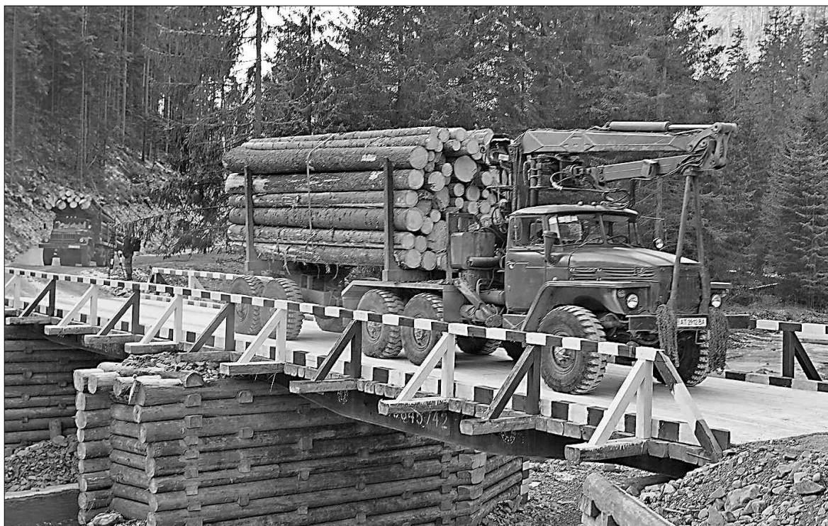
Новозбудованим мостом через урочище Григітливий, що на території Піскавського лісництва, сміливо їдуть великовантажні лісовози
