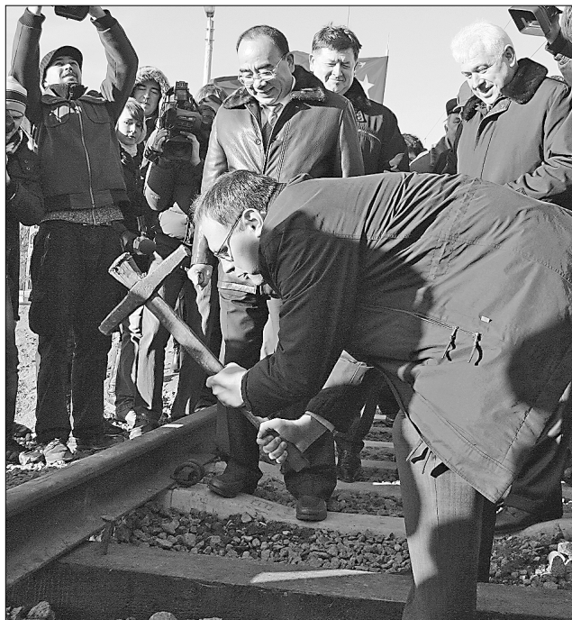
Ще один удар — і «срібний костиль» покладе початок будівництва «Повітряного експреса»
