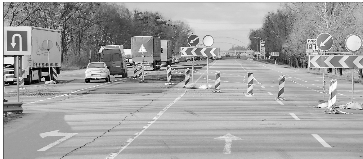
В окремих районах через об'єктивні причини ремонт триватиме до середини липня
