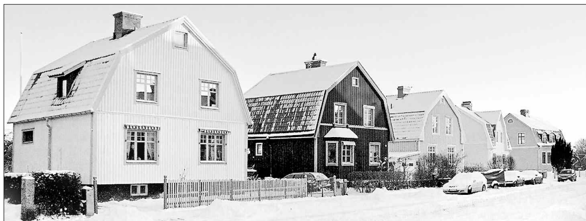
Це енергоефективні будинки у Швеції. Досвід шведів не буде зайвим і українцям
