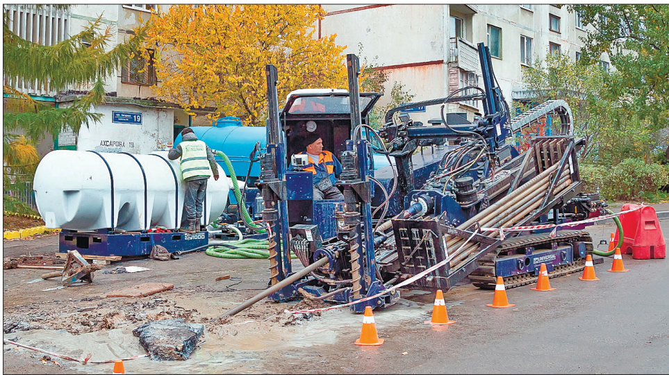
Майстри виконують заміну водоводів методом горизонтально направлено буріння
