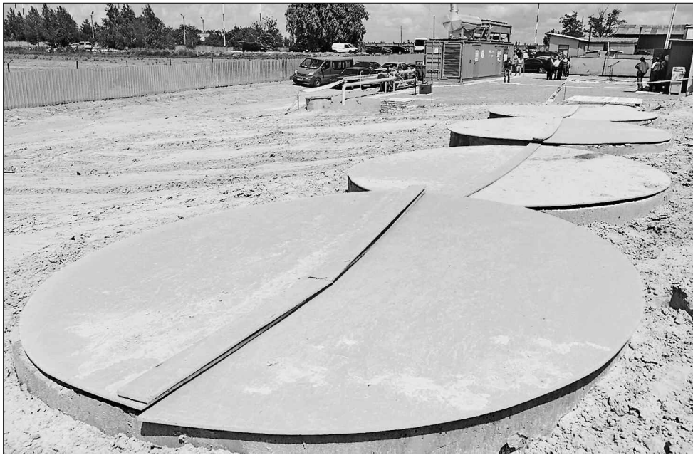
Є в Україні електростанції, як ця, які виробляють енергію з відходів
