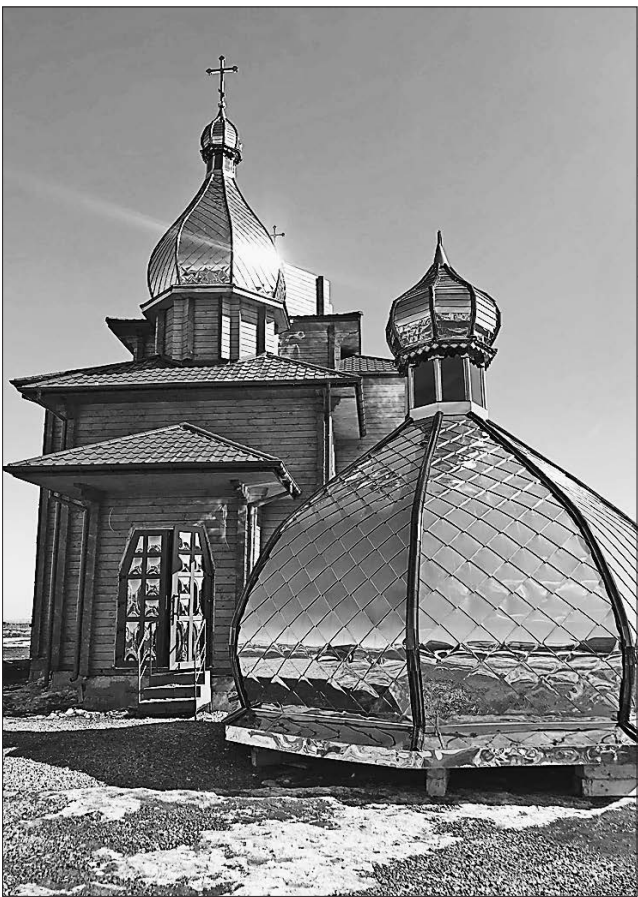
Уже зведено церкву, дзвіницю, капличку, гуманітарний центр, тривають внутрішні роботи
