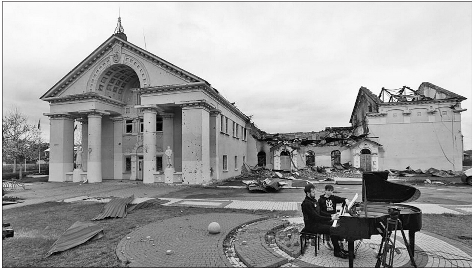
Пошкоджений будинок культури міста Ірпінь
