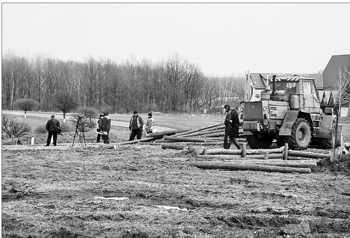
Спорудження взводно-опорного пункту на белгородському напрямку
