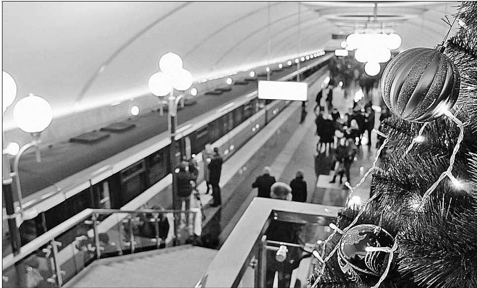
Станцію «Виставковий центр» метробудівці, як і обіцяли, подарували киянам під ялинку
