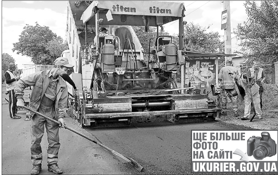
Заміна верхнього шару дорожнього покриття на вулиці Спартак у селищі Яківці на околиці Полтави
