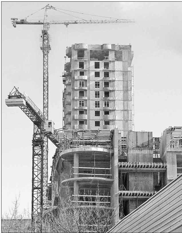
Будівельники завершують зведення житла, яке розпочали ще до кризи
