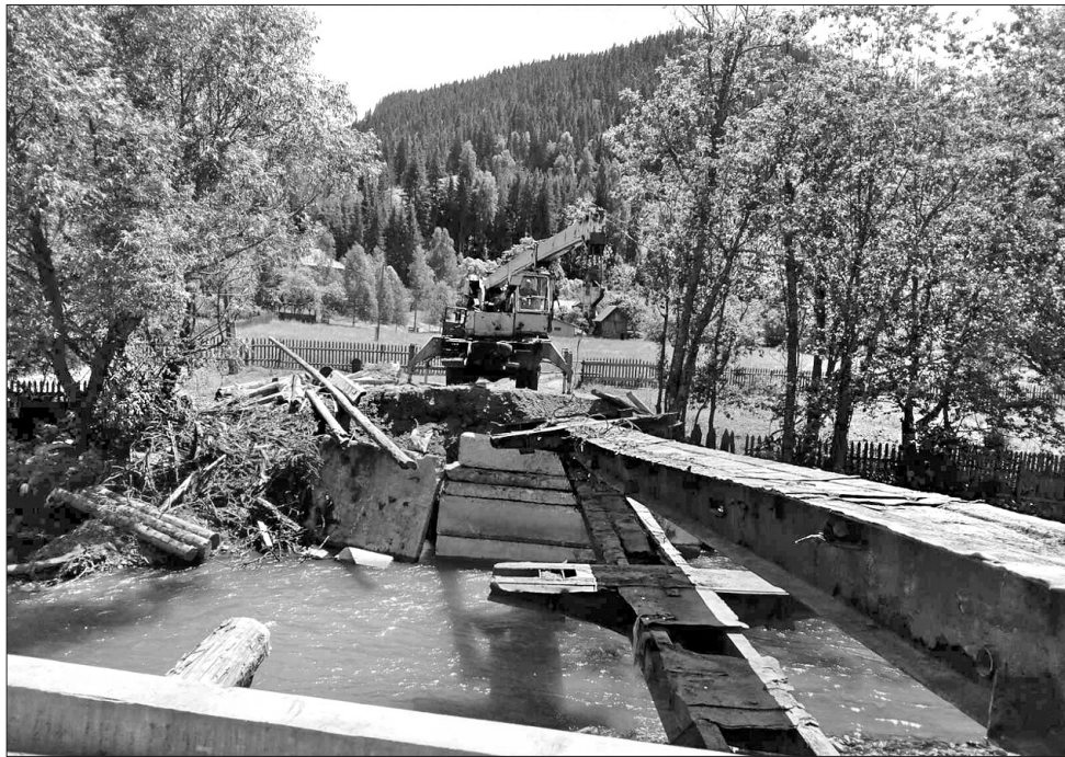
Завдяки місцевим підприємцям на території села швидко відновили кладки і один зі зруйнованих мостів через Сучаву
