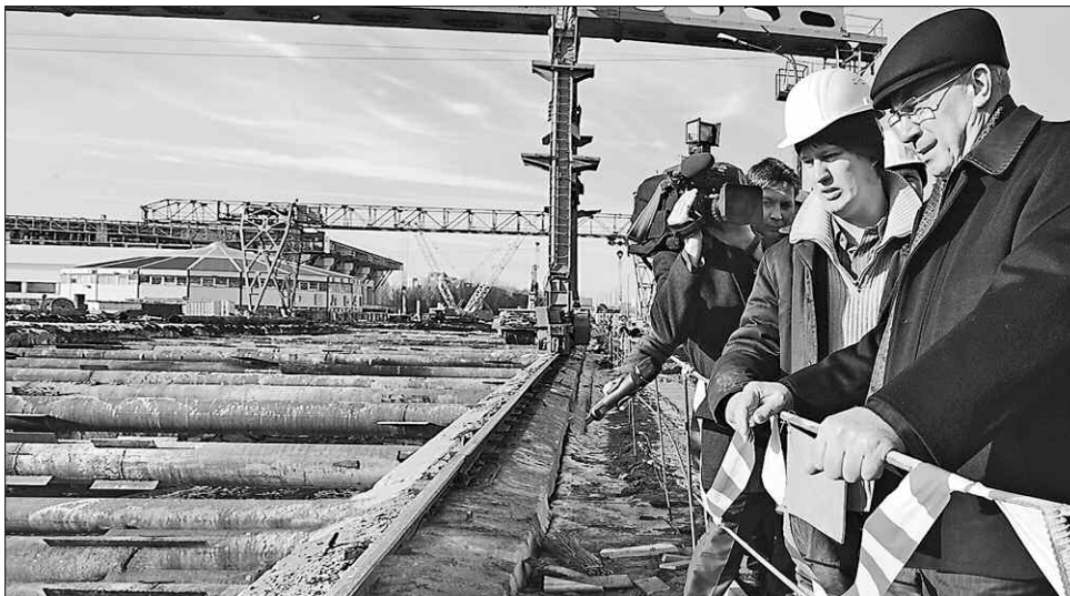
За півроку котлован перетвориться на ошатну станцію «Іподром»
