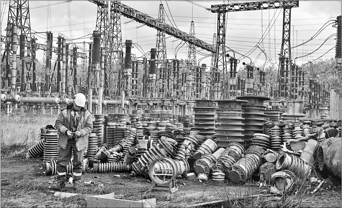
Нині ремонт і відновлення пошкоджених об'єктів енергетичної інфраструктури ми займаємось цілодобово
