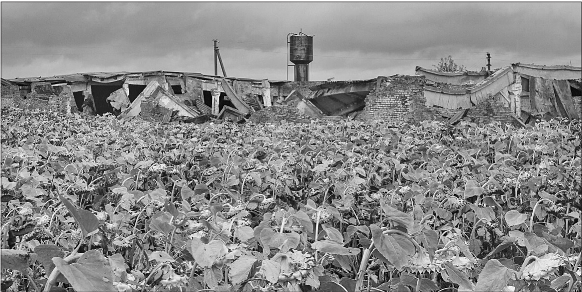
Обстріл того дня тривав майже три години, внаслідок чого зруйнований склад і згоріло 350 тонн готового сіна
