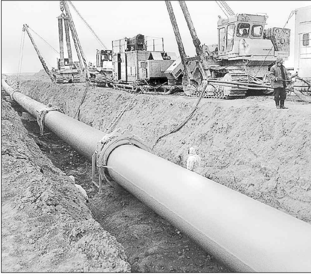
Комплекс ремонту трубопроводів. Переізоляція
