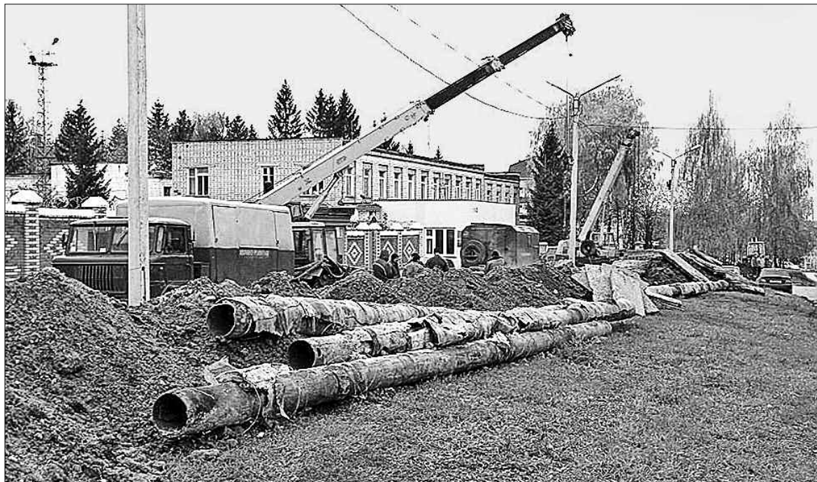
Утеплювати труби треба під час прокладання
