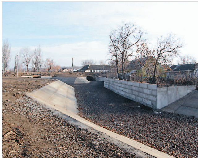
Роботи з укріплення балки вийшли на фінішний етап
