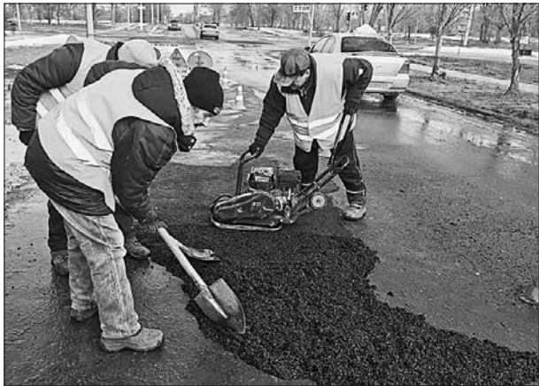
До ремонту автошляхів Северодонецька стала перша бригада
