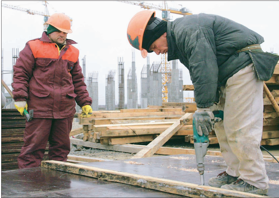
Будівництво офісів та техногенних будівель і надалі жорстко контролюватиметься
