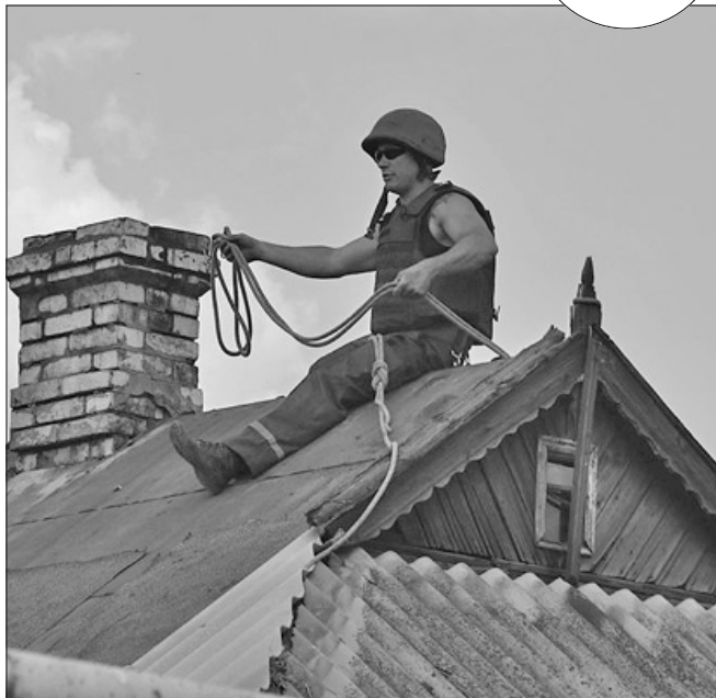
Рятувальники ремонтують пошкоджені дахи хат у Мар'їнці
